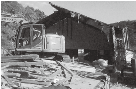
旧南小学校体育館解体工事
