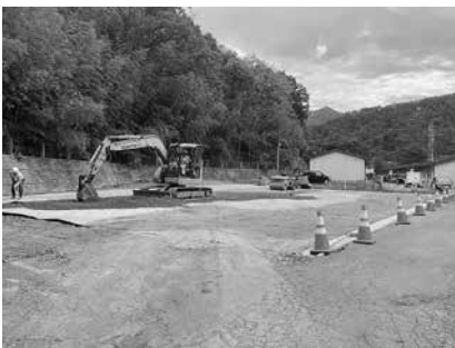
旧南小学校解体工事
