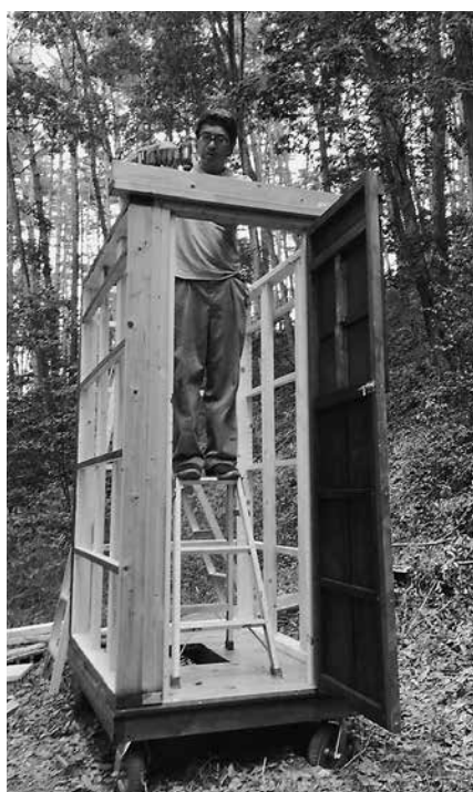
床と骨組みを区組み立てて製作
