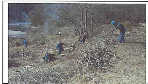
【伐採作業の状況】
