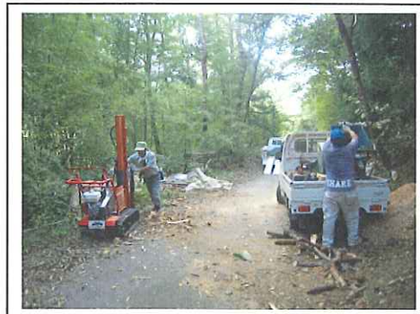
【巻き割り作業・破碎作業状況】
