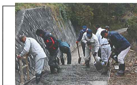
【道路舗装作業】
