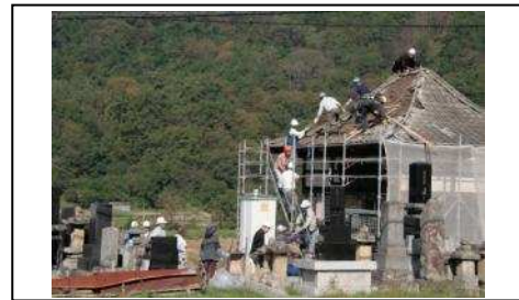
【施設整備作業】
