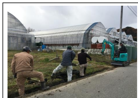
【側溝の泥上げ作業の様】
