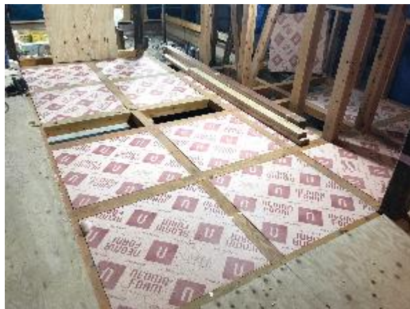
千曲市 古民家リノベーション床断熱 出典：中澤勝一建築ホームページ
