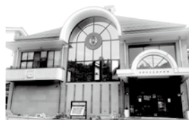
中学校校舎・体育館 1998 年築
