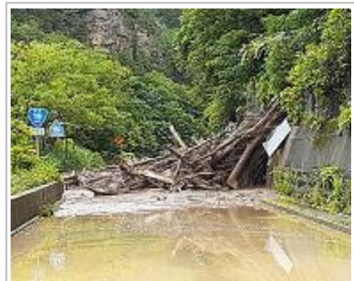
図 5 豪雨による国道 19 号土砂崩れ (出典 国土交通省)
