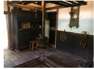
古民家脱炭素リノベーション
